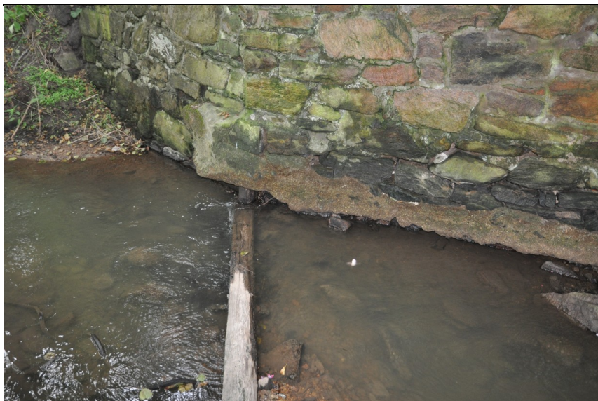
Opěra 1 vpravo. Dřevěný práh je propadlý, voda podemílá opěru.
