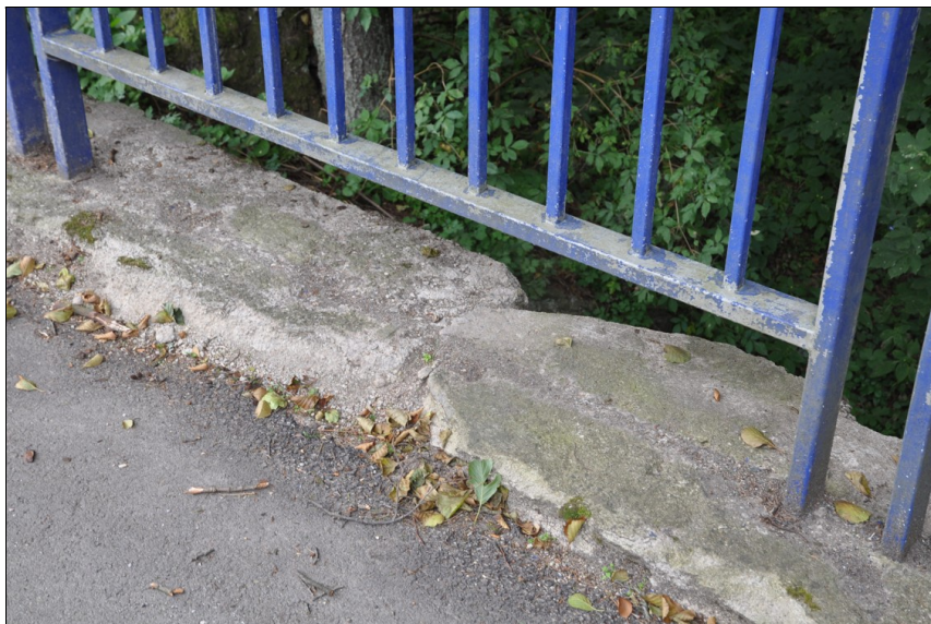
Zábradlí a římsa vpravo, nátěr zábradlí se odlupuje.
